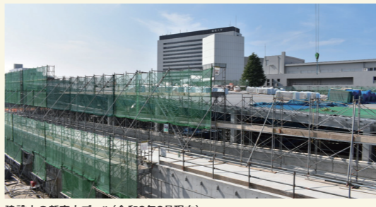
建設中の新室内プール(令和2年8月現在)
